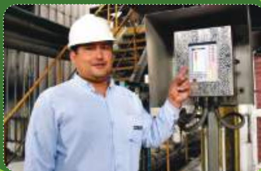
Indicador remoto para visualización de nivel del operador
